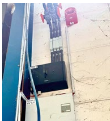
Rauchansaugsystem: komplexes System für maximale Sicherheit.
