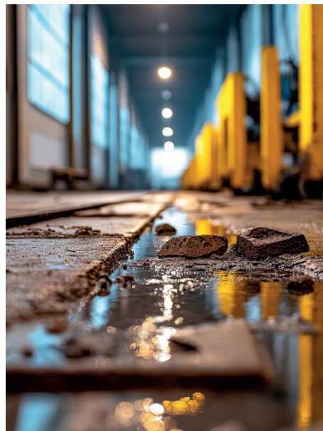
Manche Mängel können umgehend beseitigt werden.
