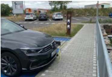
Prüfungen und geschulte Mitarbeitende stärken den Brandschutz im Fuhrpark.
