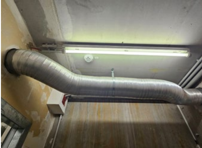
Auch Lüftungsrohre unterliegen den Anforderungen der (Muster-)Leitungsanlagen-Richtlinien.
