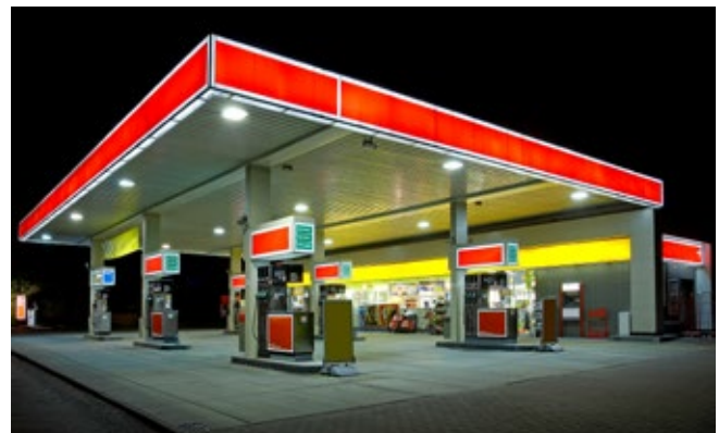
Für einen sicheren Betrieb ist Brandschutz an allen Tankstellen eine der wichtigsten Schutzmaßnahmen.
