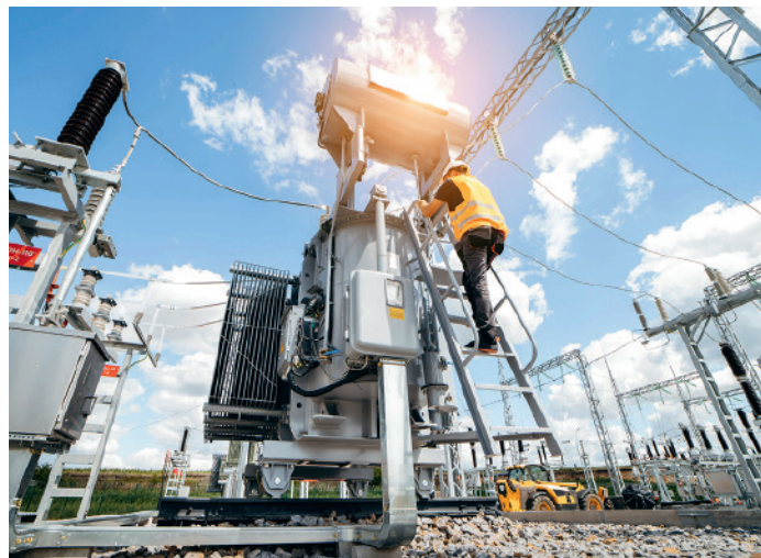
Gut strukturierte Arbeitshilfen unterstützen Mitarbeitende im professionellen Umgang mit Gefahrstoffen.
