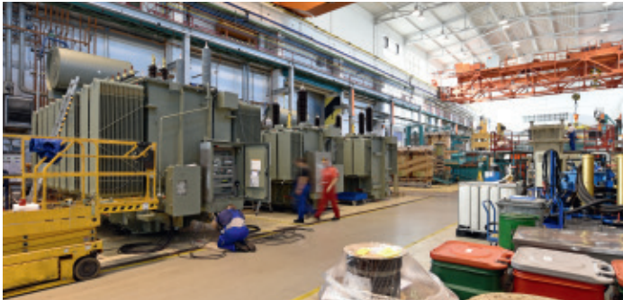
Beinahe-Explosion in der ATEX-Zone: ein kleiner Fehler mit großer Wirkung.
